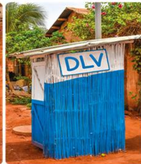
Toilette double fosse Chasse Manuelle – WC Mimin (toilette de démonstration)
