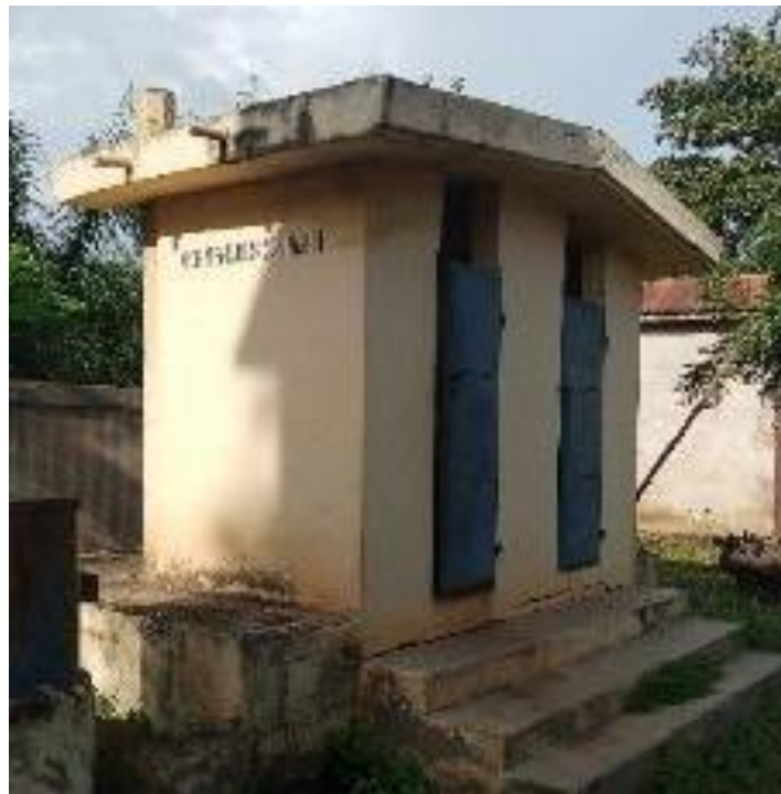
Latrine VIP double fosse étanches et surélevées (Lokossa 2008)
