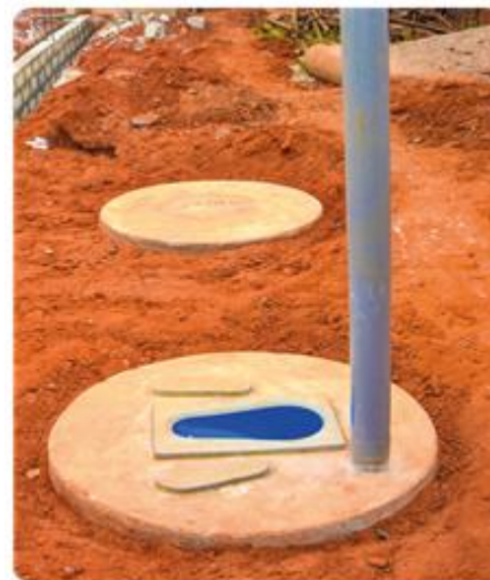
Toilette double fosse Chasse Manuelle – WC Mimin (toilette de démonstration)
