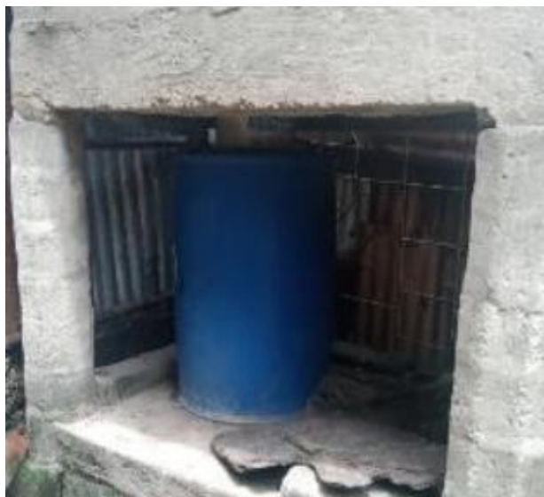
Latrine à tinette ( Ahouansori-Toweta )
