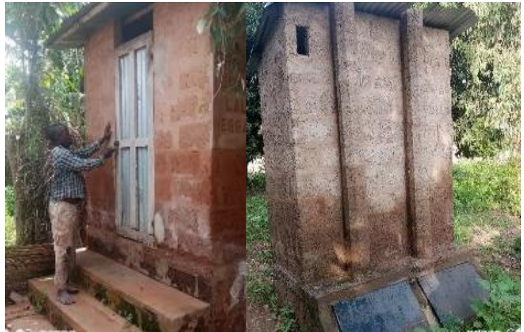
Latrine ECOSAN à fosses surélevées (Lalo - 2006 & Dassa Zoume 2017)
